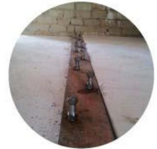
É composto por aço de alta resistência, **superior a 800 MPa**, devidamente trabalhado com fio **Toque automático** na sua parte mais lenta de forma que melhorar a fixação mecânica no metal. Tem um perfil em forma no seu topo para se juntar à laje de concreto.
