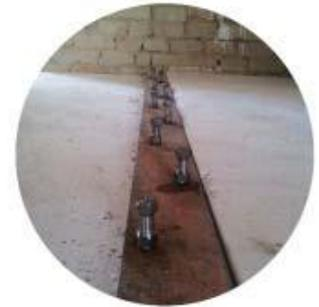
Das Material, aus dem es besteht, ist ein hochfester Stahl **mit mehr als 800 MPa**, der im unteren Teil mit einem **selbstverriegelnden** Gewinde für die mechanische Verankerung im Metallprofil versehen und im oberen Teil für die Verankerung in der Betonhaube
